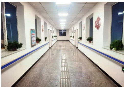
提质改造后的教学楼三楼走廊
